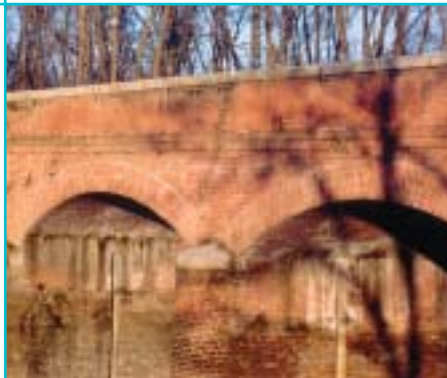
Ponte sul canale Villoresi.
